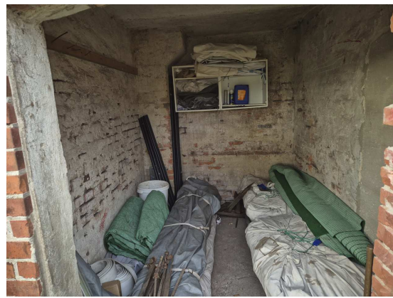
Abbildung 78 Lagerraum auf Straßenseite
