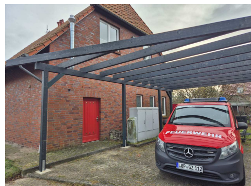
Abbildung 61 Rückseite mit Carport (im Bau)
